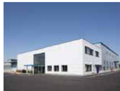
建設技術教育センター外観
