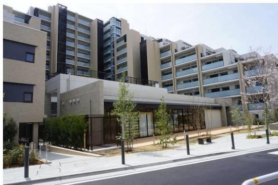
公開空地にはかまどベンチや防災井戸を設置。 隣接する小学校と連携して活用できるようにしています。
