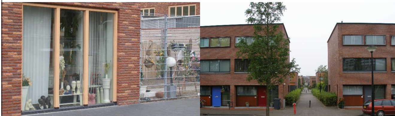
CPTEDの戦略に基づき建て替えられたオランダの市営住宅団地
