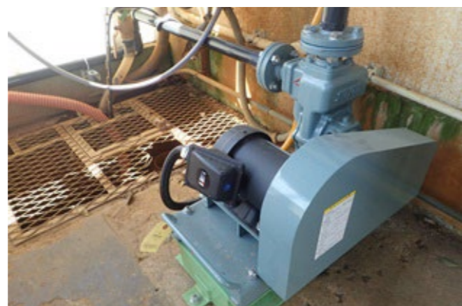
排水処理場 凝集汚泥返送ポンプ
