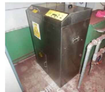
廃シンナー蒸留再生装置
