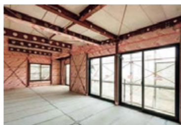
鉄骨とヘーベル板だけの状態にしてからのリフォーム
