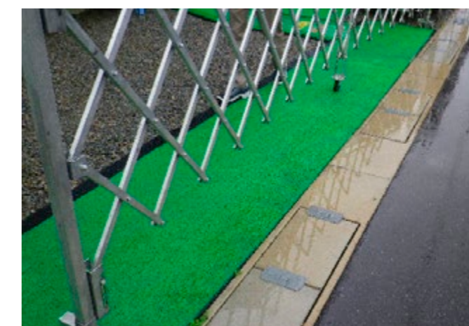
道路との境界に敷いたマット
