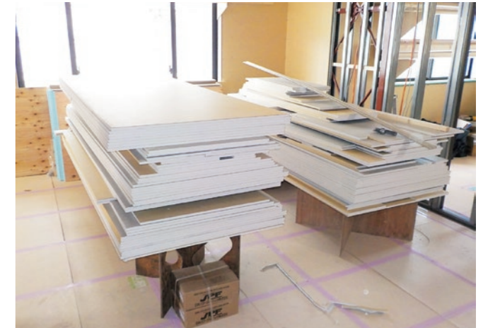
工場加工(プレカット)された石膏ボード
