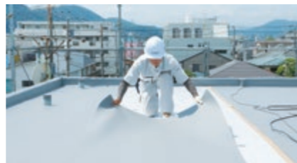
30年の耐久性を実現する屋上防水工事
