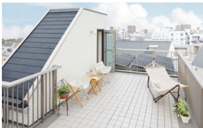
太陽光発電システム×屋上利用
