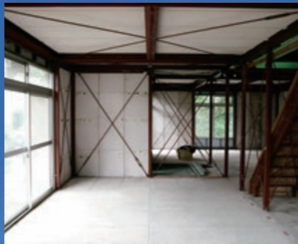
改築途中で現れたヘーベルハウスの躯体
