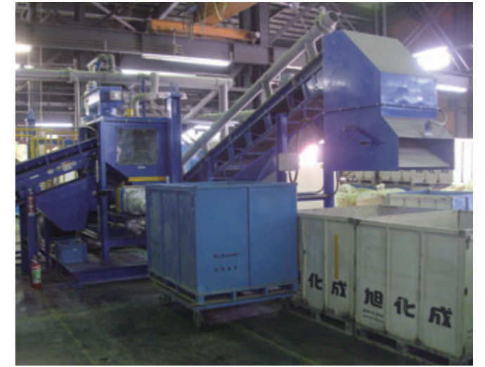
RPF製造設備
