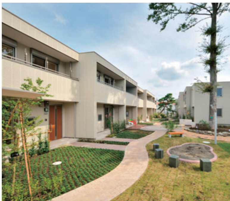
「母力むさしの」の特長として、アクセスモコン(中庭)があります。中庭は敷地内の動線上にあり、各戸とも玄関とリビングが中庭に面しているため、自然な声かけ・見守りが生まれます。
