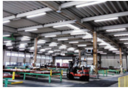
滋賀工場E棟倉庫の蛍光灯248台を省エネ高効率型に更新
