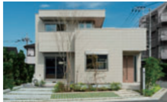
街かどヘーベルハウス アトラス上大岡ガーデン外観
