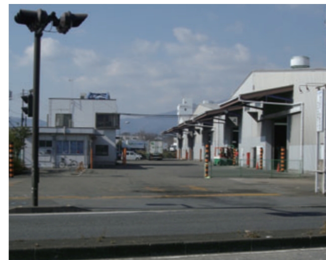
厚木資源循環センター
