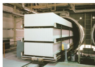
へーベル（ALC）の製造工程
