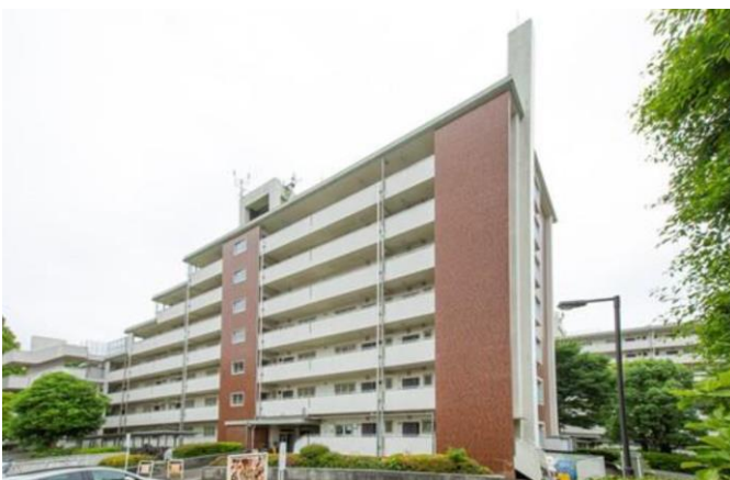
従前の給田北住宅(2022 年 6 月撮影)
